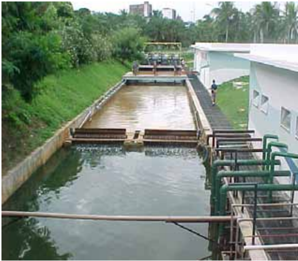
Figura 5. Estação de tratamento do rio Carioca: Remoção de lodo flotado (Fotos: DIAS, A.P.15/04/03).
