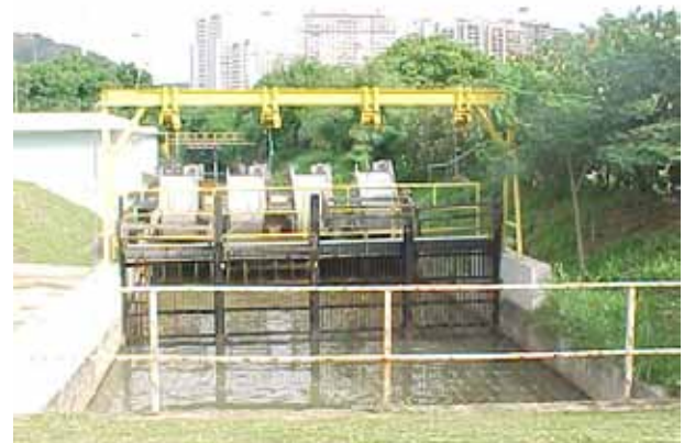
Figura 6. Estação de tratamento do rio Carioca: Estrutura de gradeamento (Fotos: DIAS, A.P.15/04/03).
